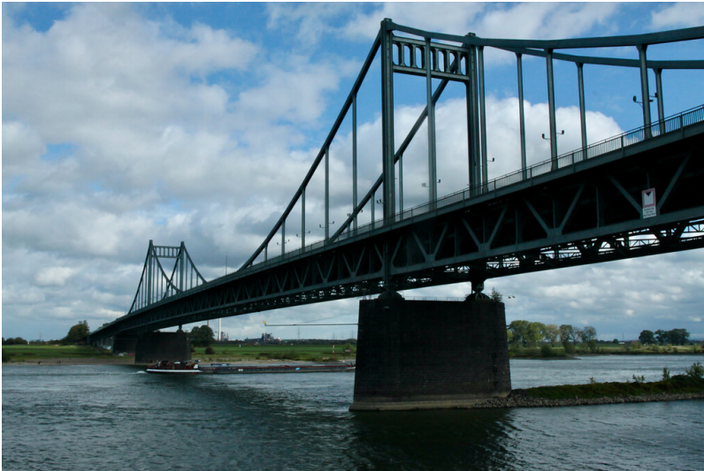
Rheinbrücke Krefeld-Uerdingen (2020) Fotograf/Urheber: Christoph Becker
