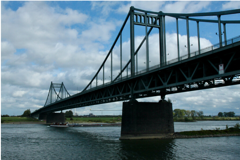
Rheinbrücke Krefeld-Uerdingen (2020) Fotograf/Urheber: Christoph Becker
