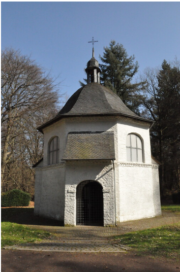
Die Ulrichskapelle bei Schloss Tüschbroich hat einen achtseitigen Grundriss und ist aus weiß geschlammten Ziegelsteinen errichtet (2021) Fotograf/Urheber: Nicole Schmitz
