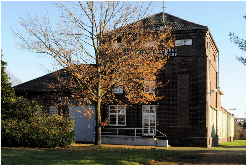
Wasserwerk Kierdorf (2020) Fotograf/Urheber: Norbert Gilson
