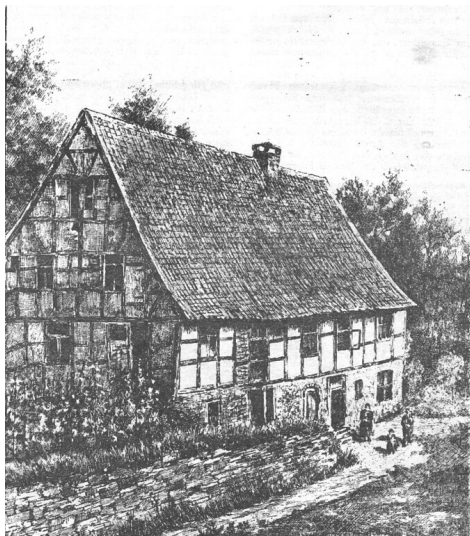
Das ehemalige Hammerwerk Bökershammer südlich von Kaltenherberg in Burscheid im Eifgental (19. Jahrhundert) Fotograf/Urheber: unbekannt
