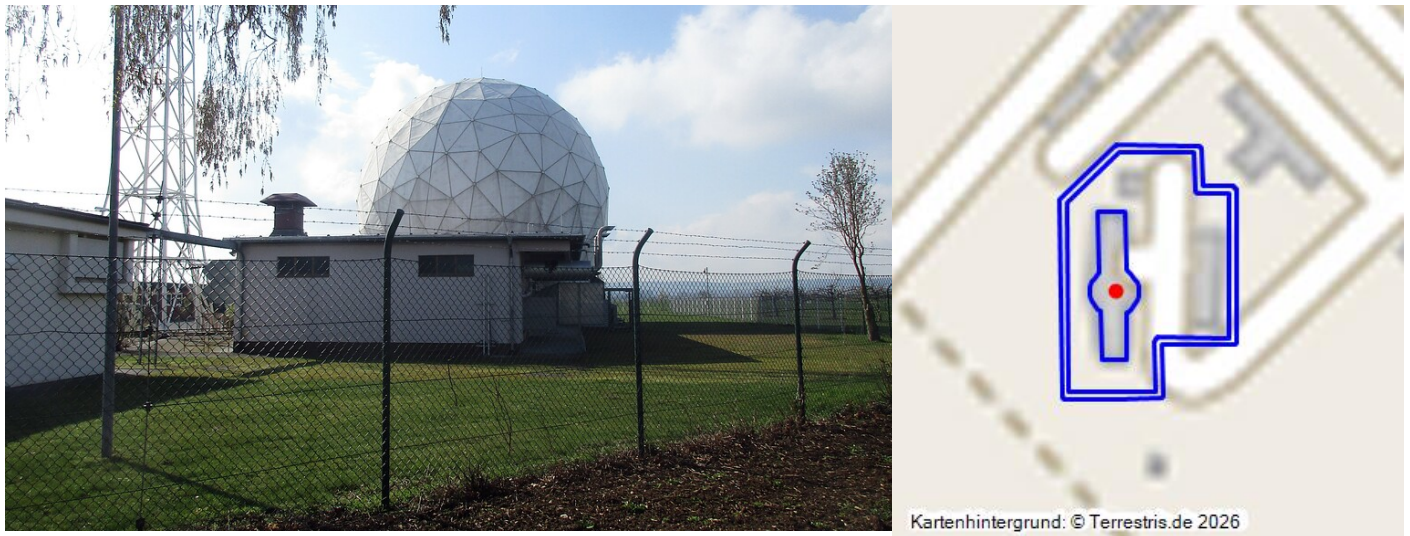
Blick auf die Radarkuppel in der Mercator-Kaserne bei Euskirchen (2021). Das vormalige "NATO-Satcom System" ist innerhalb der Bundeswehr-Kaserne nochmals separat gesichert und eingezäunt. Fotograf/Urheber: Franz-Josef Knöchel
