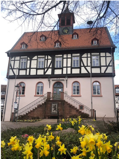
Altes Rathaus in Bad Vilbel (2021) Fotograf/Urheber: Tino Kalning
