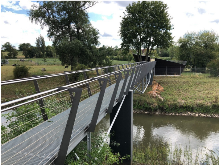
Der Römerbrunnen-Steg in Bad Vilbel (2019) Fotograf/Urheber: Michael Falk
