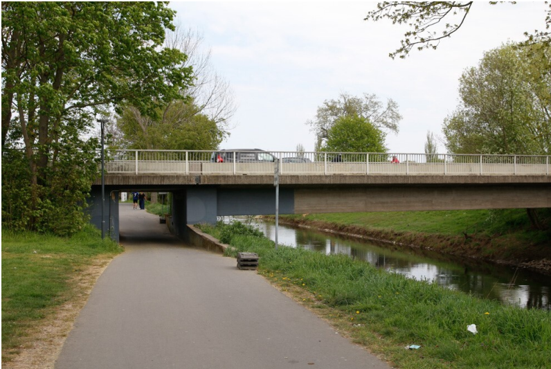
Die Straßenbrücke der Landesstraße 3008 in Bad Vilbel (2020) Fotograf/Urheber: Michael Falk
