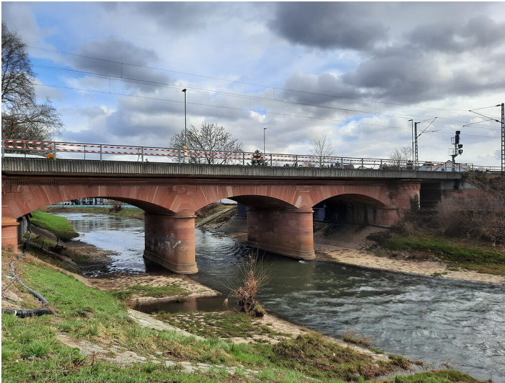
Eisenbahnbrücke der Main-Weser-Bahn über die Nidda in Bad Vilbel (2021) Fotograf/Urheber: Barbara Bernard
