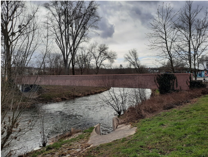
Schwimmbadsteg in Bad Vilbel (2021) Fotograf/Urheber: Barbara Bernard
