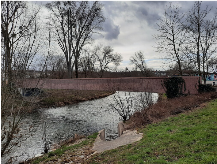
Schwimmbadsteg in Bad Vilbel (2021) Fotograf/Urheber: Barbara Bernard
