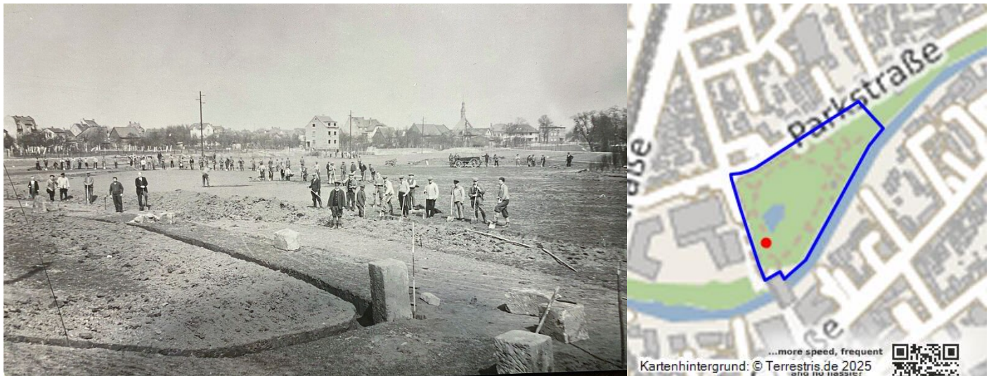
Bau des Kurparks Bad Vilbel (1934) Fotograf/Urheber: unbekannt
