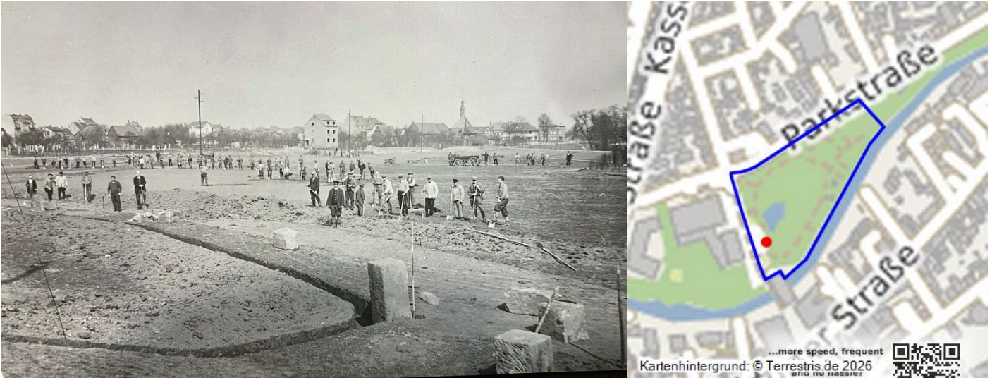
Bau des Kurparks Bad Vilbel (1934) Fotograf/Urheber: unbekannt
