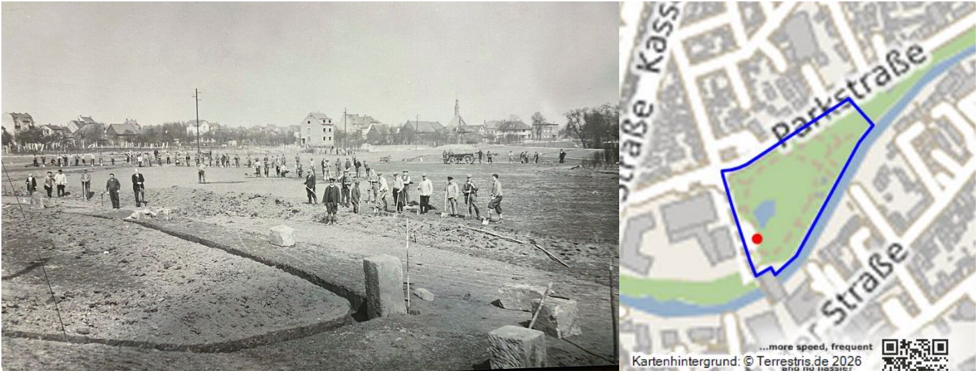
Bau des Kurparks Bad Vilbel (1934) Fotograf/Urheber: unbekannt
