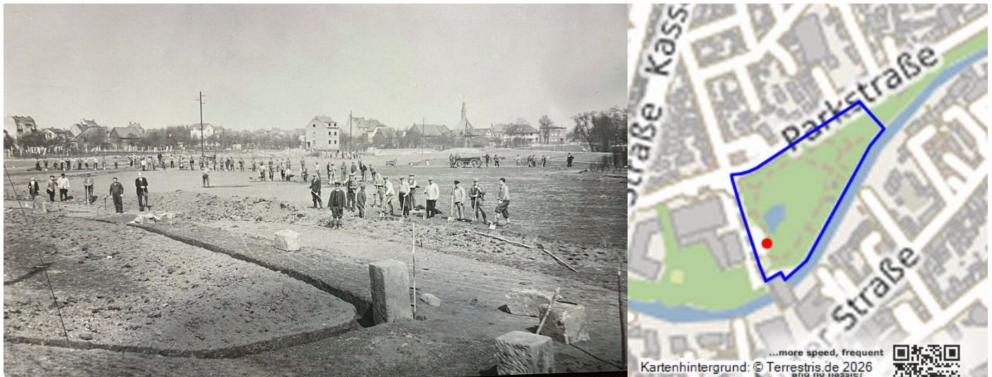
Bau des Kurparks Bad Vilbel (1934) Fotograf/Urheber: unbekannt
