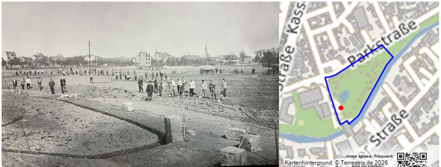
Bau des Kurparks Bad Vilbel (1934) Fotograf/Urheber: unbekannt
