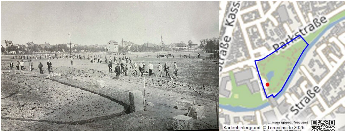
Bau des Kurparks Bad Vilbel (1934) Fotograf/Urheber: unbekannt
