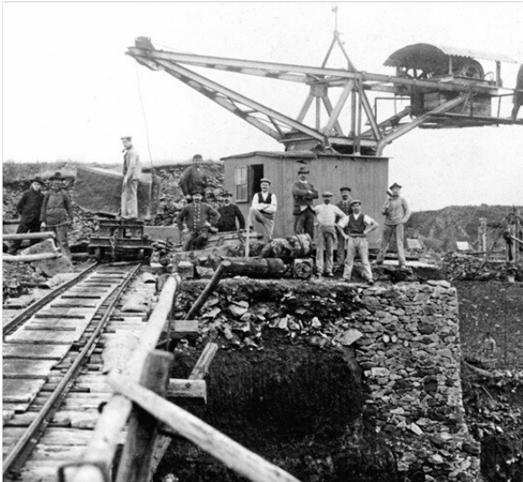
Früher Grubenkran mit Elektromotor (um 1905). Fotograf/Urheber: unbekannt
