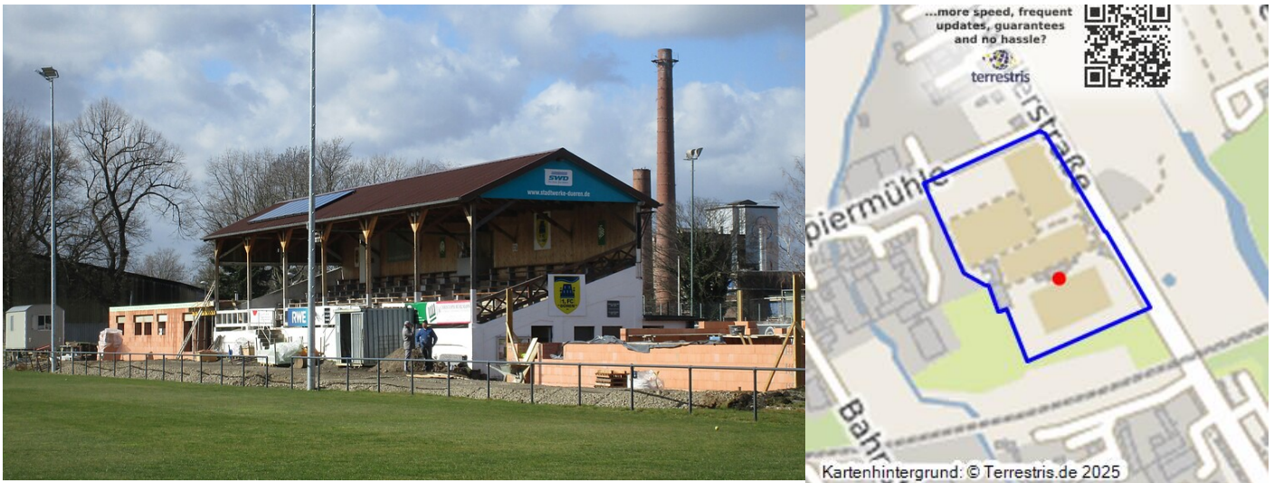
Die Tribüne der Dürener Westkampfbahn, die als die älteste Fußball-Holztribüne in Deutschland gilt (2021). Bei den Bauarbeiten werden moderne Umkleideanlagen beiderseits der Tribüne ergänzt. Fotograf/Urheber: Franz-Josef Knöchel
