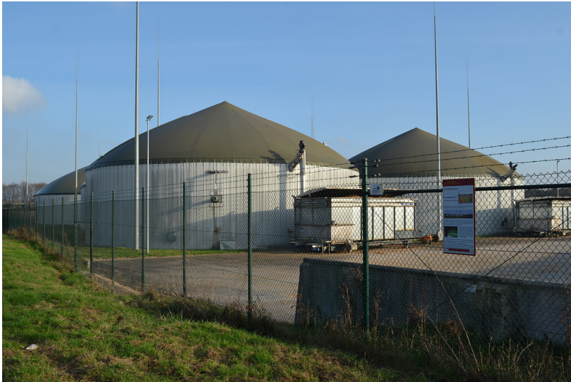
Erzählstation "Biogasanlage" am Kölner Randkanal in Roggendorf/Thenhoven (2015) Fotograf/Urheber: Reinhard Zeese
