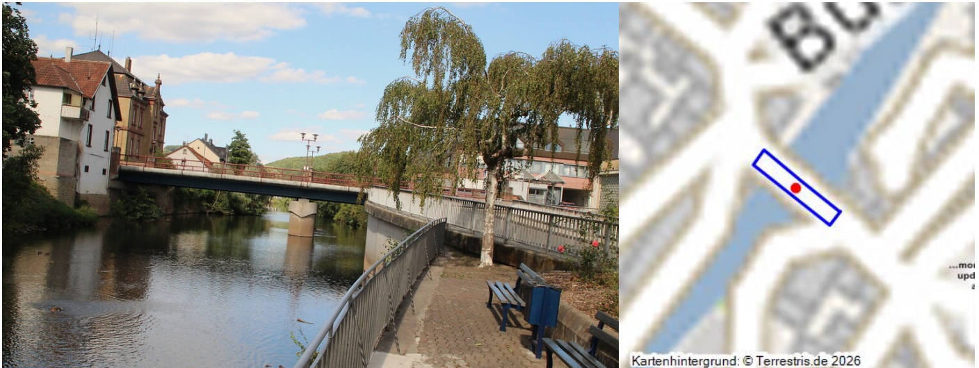
Die Glanbrücke in Lauterecken (2020) Fotograf/Urheber: Guido Schönfelder; Stadt Lauterecken
