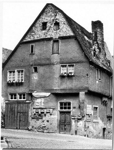
Das Fachwerkhaus Hauptstraße 88 in Briedel, die sogenannte "Alte Grafschaft" (1930er Jahre). Fotograf/Urheber: unbekannt
