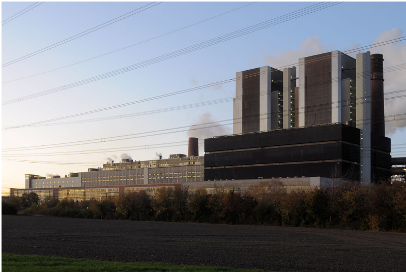
Kraftwerk Weisweiler (2020) Fotograf/Urheber: Norbert Gilson
