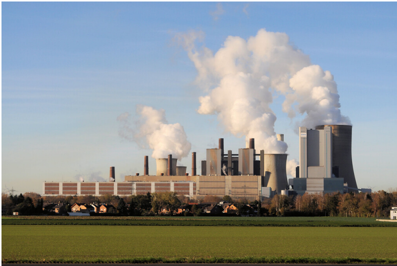
Kraftwerk Niederaußem (2020) Fotograf/Urheber: Norbert Gilson
