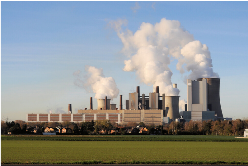
Kraftwerk Niederaußem (2020) Fotograf/Urheber: Norbert Gilson
