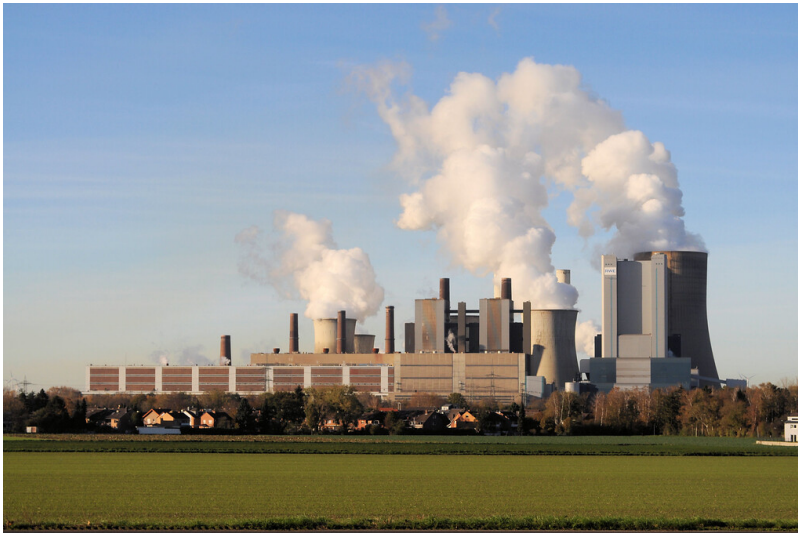
Kraftwerk Niederaußem (2020) Fotograf/Urheber: Norbert Gilson
