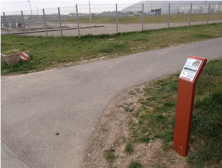
Erzählstation "Regenwasserbehandlung" am Kölner Randkanal (2014) Fotograf/Urheber: Reinhard Zeese
