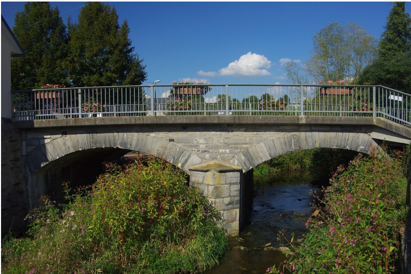
Lahnmarmorbrücke in Eschenau (2020) Fotograf/Urheber: Ulrich Belz
