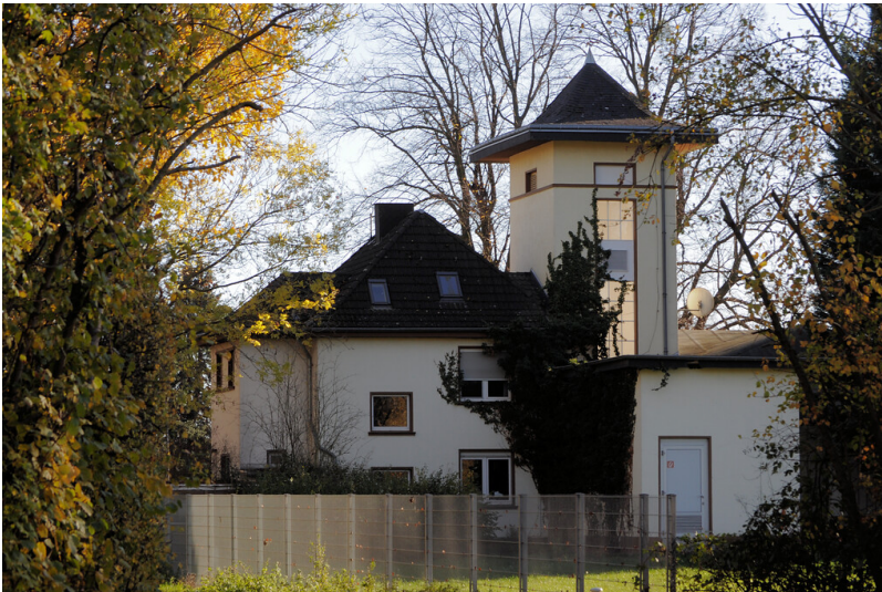
Wasserwerk Glesch (2020) Fotograf/Urheber: Norbert Gilson
