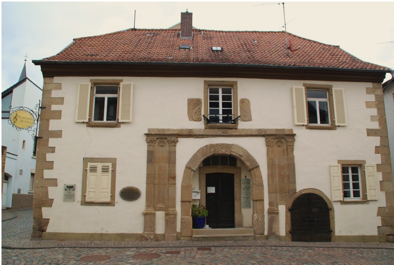
Frontansicht Schlossgasse 1 (2020) Fotograf/Urheber: Schönfelder, Guido
