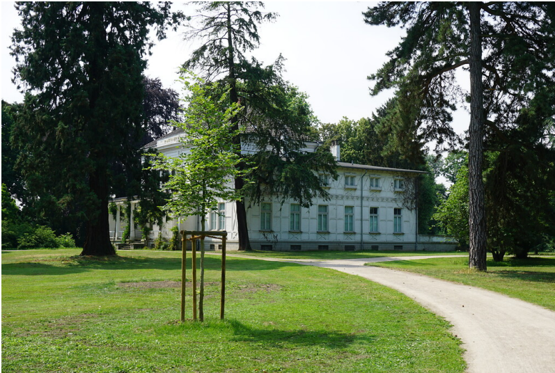
Haus Lantz in Düsseldorf-Lohausen, Ansicht von Nordost (2018) Fotograf/Urheber: Claus Weber
