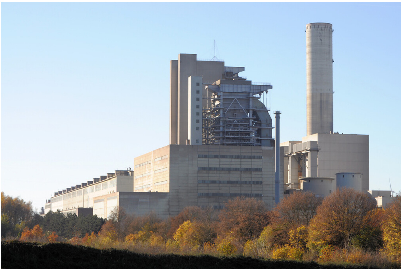
Kraftwerk Frimmersdorf II (2020) Fotograf/Urheber: Norbert Gilson
