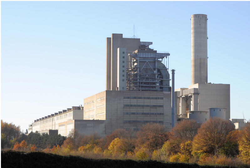
Kraftwerk Frimmersdorf II (2020) Fotograf/Urheber: Norbert Gilson
