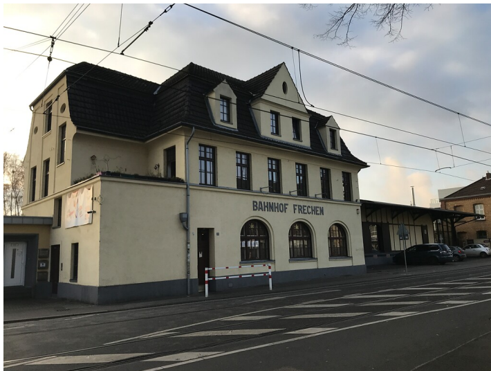
Empfangsgebäude von 1913 mit Güterschuppen am Bahnhof Frechen (2021) Fotograf/Urheber: Nicole Schmitz
