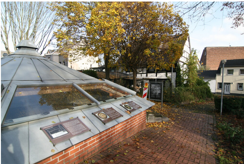
Ensemble aus überdachten Töpferöfen und zugehörigem Wohnhaus in Fachwerkbauweise in der Broichgasse (2021) Fotograf/Urheber: Nicole Schmitz
