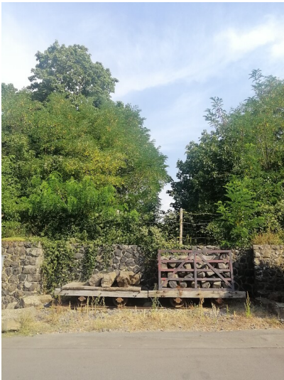
Blick auf die ehemalige südliche Zufahrt zum Dattenberger Steinbruch, heute eine Informationsstation (2020). Fotograf/Urheber: Leonie Immerath
