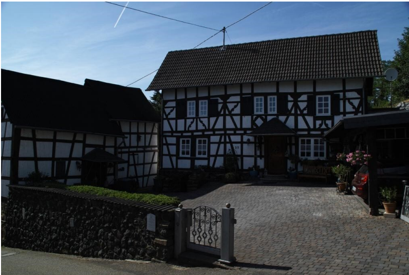
Blick auf den Ehrensteiner Hof in der Burgstraße in Dattenberg (2020) Fotograf/Urheber: Wolfgang Korf
