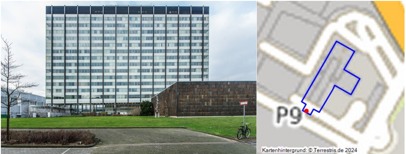
KHD-Verwaltungsgebäude (Hochhaus) (2018) Fotograf/Urheber: Jürgen Gregori
