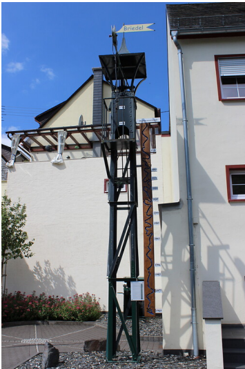
Fährturm an der Moselstraße in Briedel (2020) Fotograf/Urheber: Anna-Maria Zois
