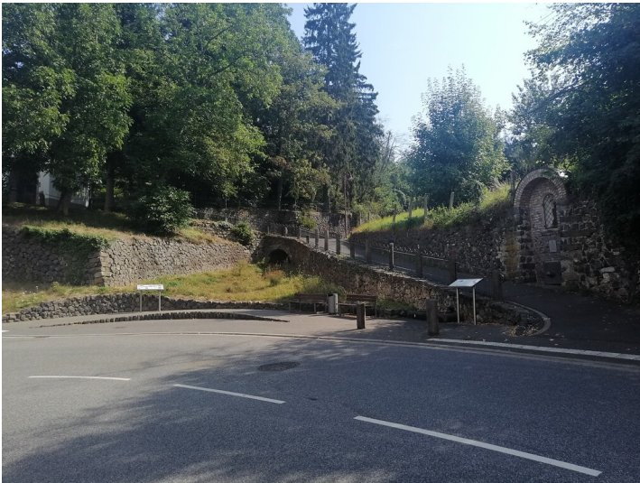
Blick auf den Platz mit dem Antoniusbrunnen (rechts in der Hangmauer) und der alten Unterführung (2020). Fotograf/Urheber: Dagmar Gombert
