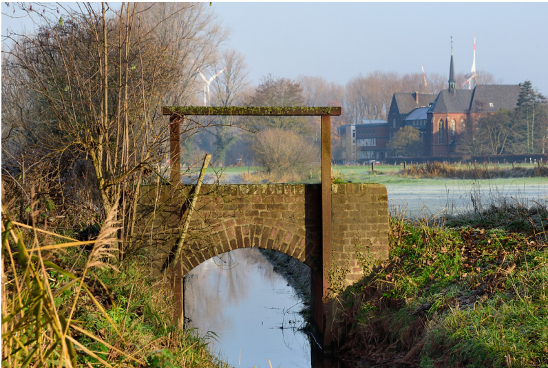
Brücke in der Nähe der Abtei Mariendonk in Grefrath (2020) Fotograf/Urheber: Hans-Georg Wende
