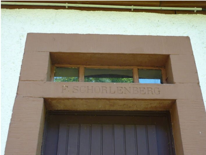
Ritterstein Nr. 179 F. Schorlenberg nordöstlich von Fischbach (2014) Fotograf/Urheber: Peter Schilling
