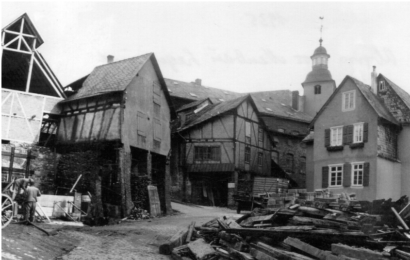
Historische Fotografie der ehemaligen Gebäude der Manufaktur Merkelbach mit Kannenofen (um 1935) Fotograf/Urheber: unbekannt
