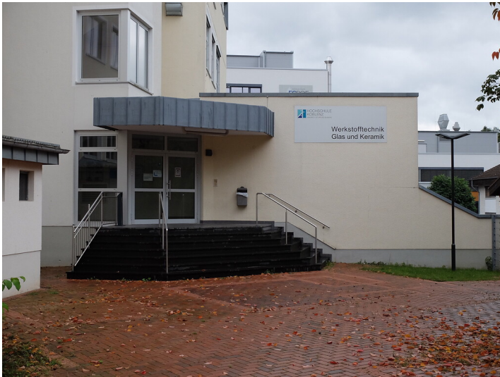
Eingang zum Institut für Werkstofftechnik Glas und Keramik des WesterWaldCampus der Hochschule Koblenz in Höhr-Grenzhausen (2020) Fotograf/Urheber: Clara Götz
