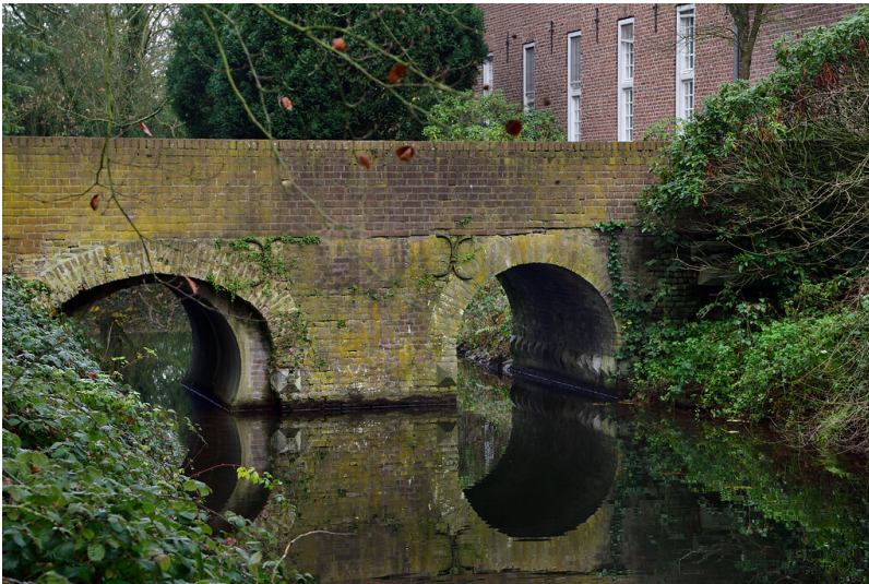
Rundbogenbrücke am Schloss Krickenbeck (2020) Fotograf/Urheber: Hans-Georg Wende
