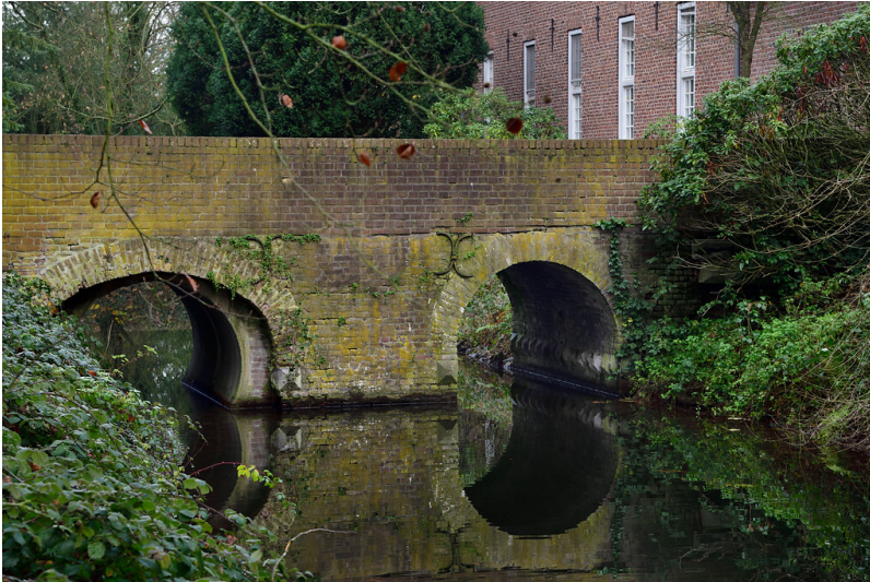
Rundbogenbrücke am Schloss Krickenbeck (2020) Fotograf/Urheber: Hans-Georg Wende
