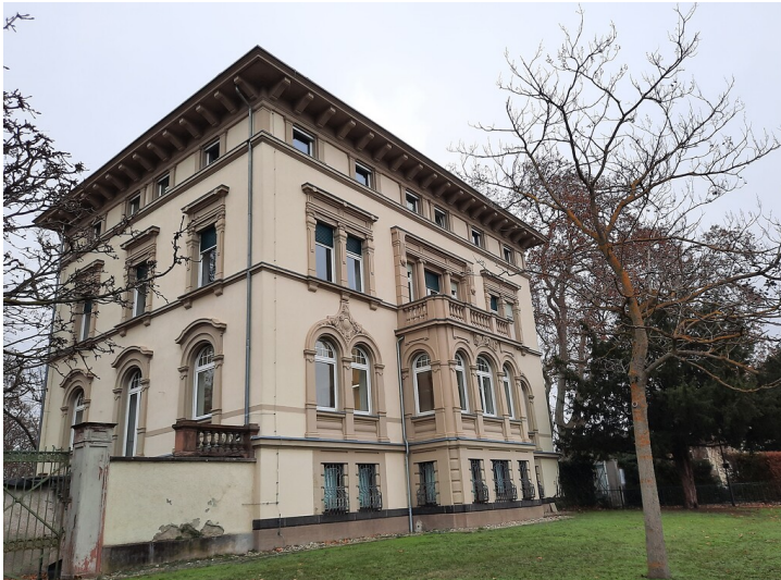
Südseite der Villa Burgeff in Hochheim am Main von der Mainzer Straße aus fotografiert (2020). Fotograf/Urheber: Barbara Bernard
