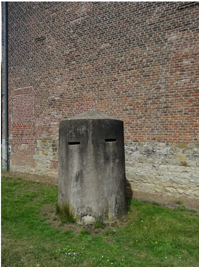
Die auf dem Gelände des Museums der früheren Glashütte Zinkhütter Hof in Stolberg-Münsterbusch erhaltene Splitterschutz-Luftschutzzelle neben der ehemaligen Fabrikantenvilla (2020) Fotograf/Urheber: Thomas Altena
