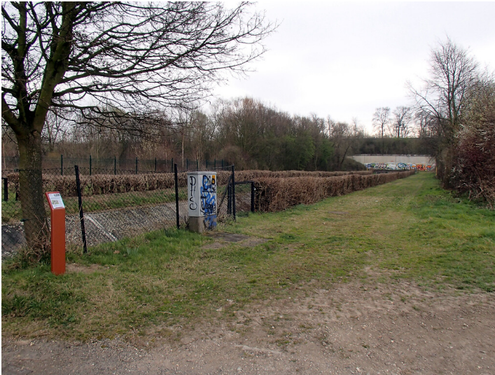
Erzählstation 2 "Kläranlage Köln-Weiden" am Kölner Randkanal (2014) Fotograf/Urheber: Reinhard Zeese
