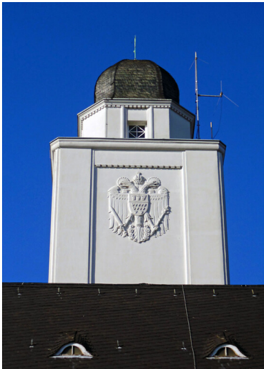
Der Meldeturm außer Dienst der Feuerwache Lindenthal in Köln-Lindenthal (2020). Fotograf/Urheber: Katharina Grünwald
