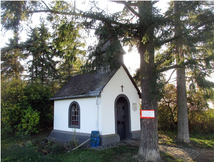
Die kleine 1912 erbaute Röder-Kapelle auf der Moselhöhe oberhalb von Niederfell (2020). Fotograf/Urheber: Franz-Josef Knöchel
