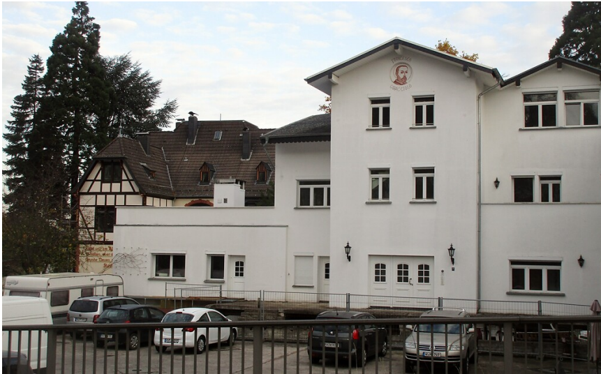
Frühere Weinkellerei und Betriebsgebäude der Remagener Hoteliers-, Weinhändler- und Rennfahrerfamilie Caracciola in der Straße Am Spich in Remagen (2020). Fotograf/Urheber: Franz-Josef Knöchel
