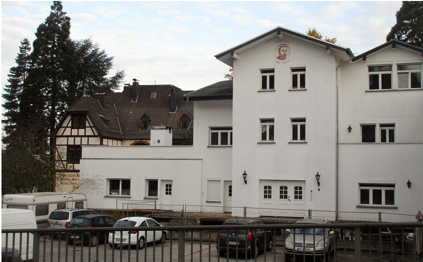
Frühere Weinkellerei und Betriebsgebäude der Remagener Hoteliers-, Weinhändler- und Rennfahrerfamilie Caracciola in der Straße Am Spich in Remagen (2020). Fotograf/Urheber: Franz-Josef Knöchel
