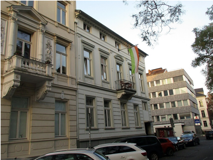
Die östliche Frontfassade der Villa in der Prinz-Albert-Straße 36 in der Bonner Südstadt (2020). Fotograf/Urheber: Franz-Josef Knöchel
